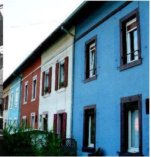
Maisons ouvrières à Guebwiller.
